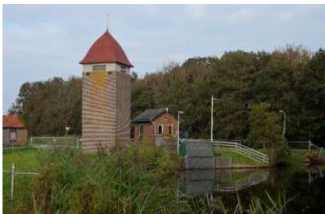
Trafogebouw en gemaal Baafjespolder
